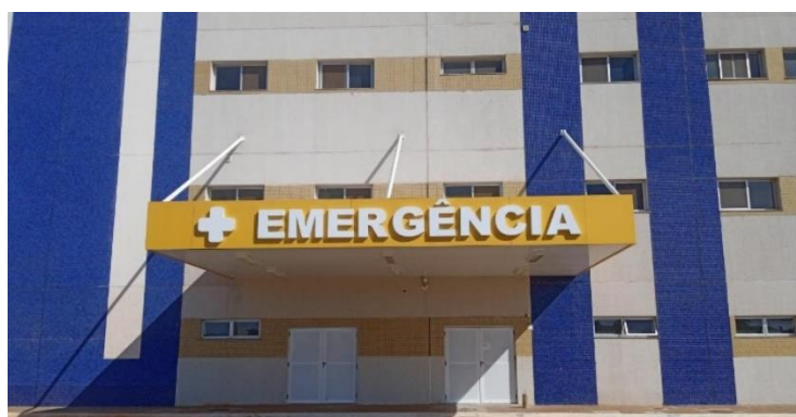
Figura 8 - Identificação visual Sala de Emergência
